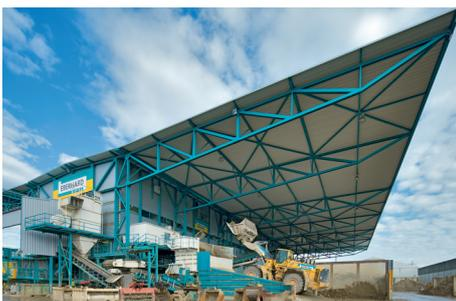
Nassmechanische Separation in der Bodenwaschanlage ESAR Rümlang
